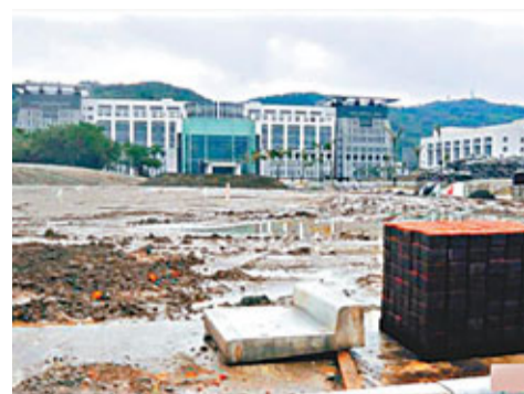
台軍的新建大樓因機電合約廠商終止契約，完工日期將延宕。
