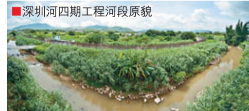
■深圳河四期工程河段原貌
