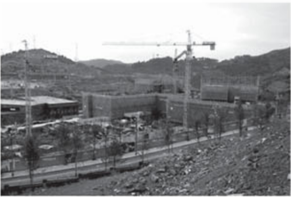
正在火熱建設中的東綫現場 虎靜攝
