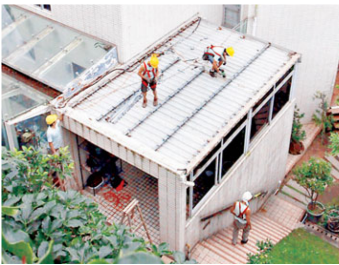
工人清拆梁宅車庫的僭建上蓋。香港文匯報記者鄧偉明攝
