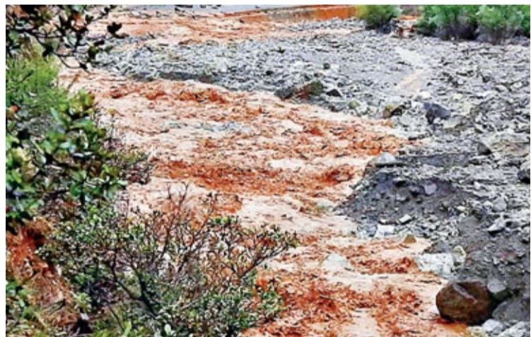
川藏公路海通溝段路面的泥石流。新華社
