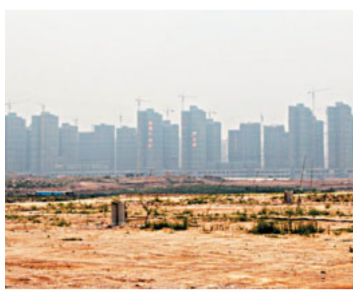
前海基礎設施建設正在快速推進。圖為前海人才公寓和保障性住房區域。香港文匯報記者李望賢攝
