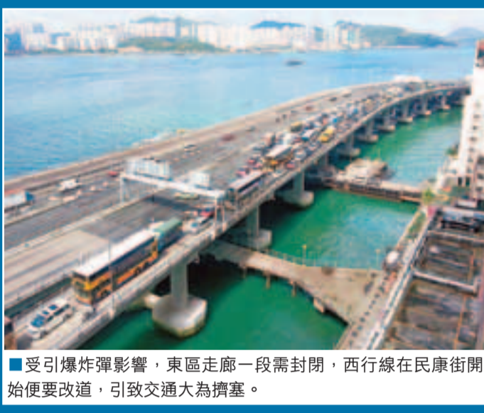
受引爆炸彈影響,東區走廊一段需封閉,西行線在民康街開始便要改道,引致交通大為擠塞。
