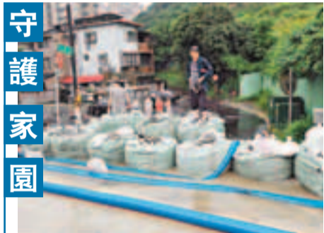
■台北市昨天又下大雨，日前萬芳抽水站出現人為故障，造成文山區大淹水，萬芳路的居民以沙包擋水，並請工務局調來抽水機抽水。 中央社
