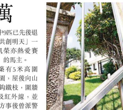
遇竊獨立屋的外圍鐵欄疑被匪徒鋸斷。
