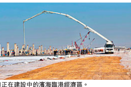
正在建設中的濱海臨港經濟區。
