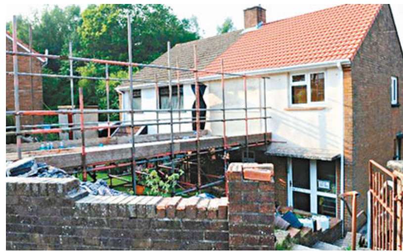
拆屋後要從路邊搭一條橋。
