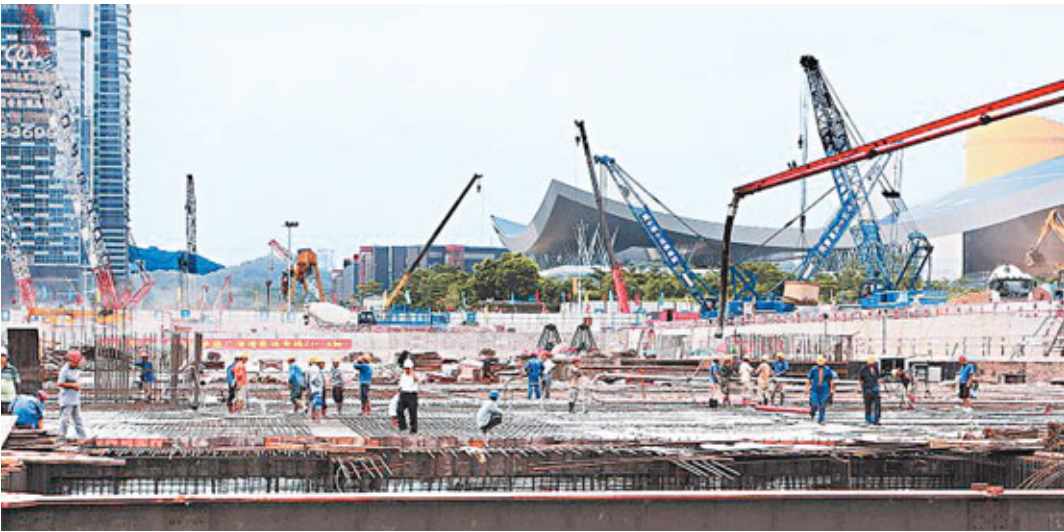
■廣深港高鐵今年將力爭建成深圳福田站，實現廣深港高速鐵路廣東段貫通。圖為福田站工地。網上圖片
