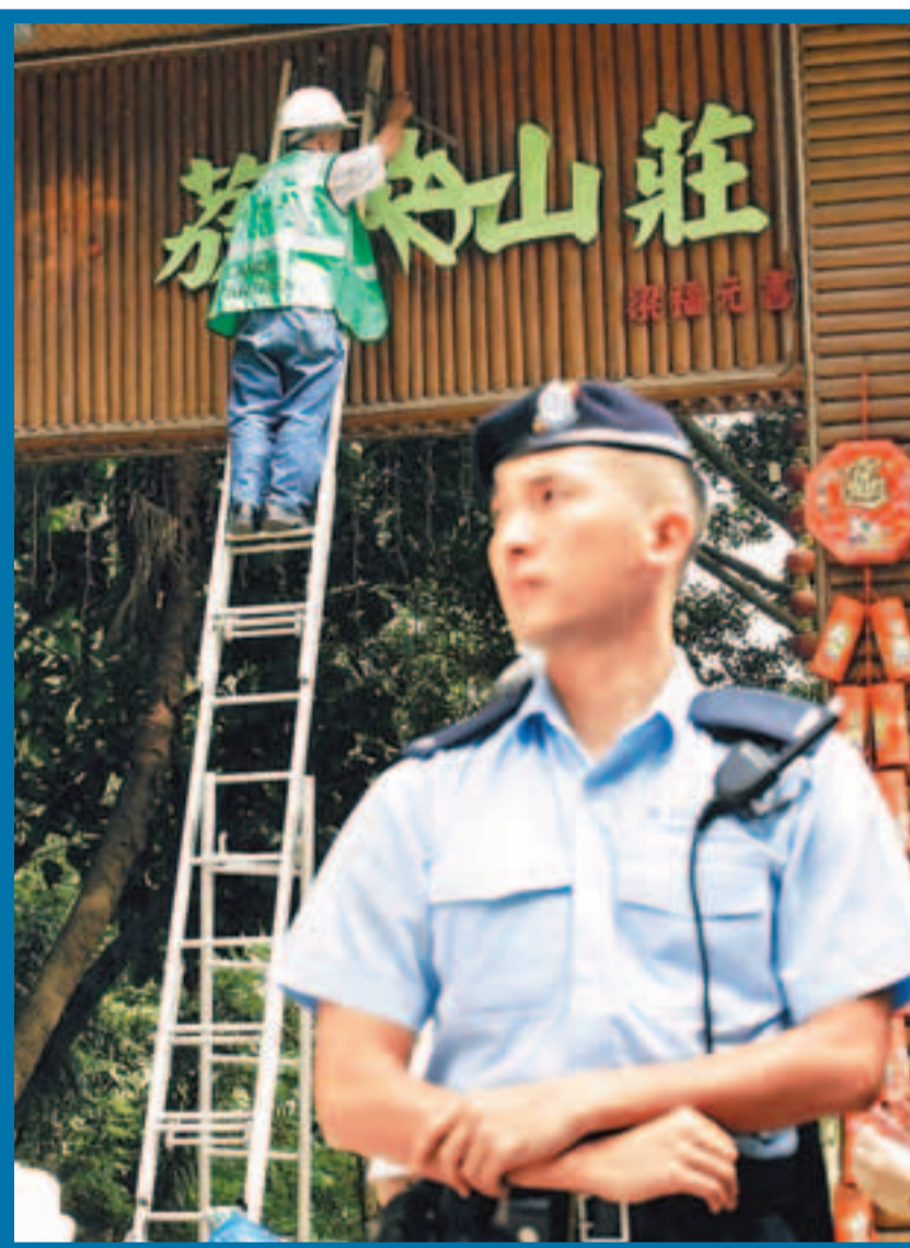
在機動部隊警員監視下，地政署外判承辦商拆除元朗大棠荔枝山莊僭建部分。
