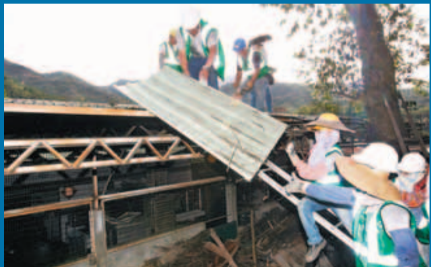
工人昨拆除大棠荔枝山莊僭建部分，再無任何阻撓。
