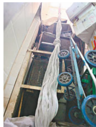
竊匪疑利用現場毗鄰大廈維修外牆鋼架的繩網結成繩索,以「盪鞦韆」方式潛入現場天井行事。
