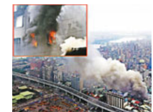
後火車站商圍的大火，數公里外可見濃煙。
