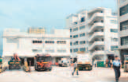
發生二級火警的青衣路化學廢料處理廠。
