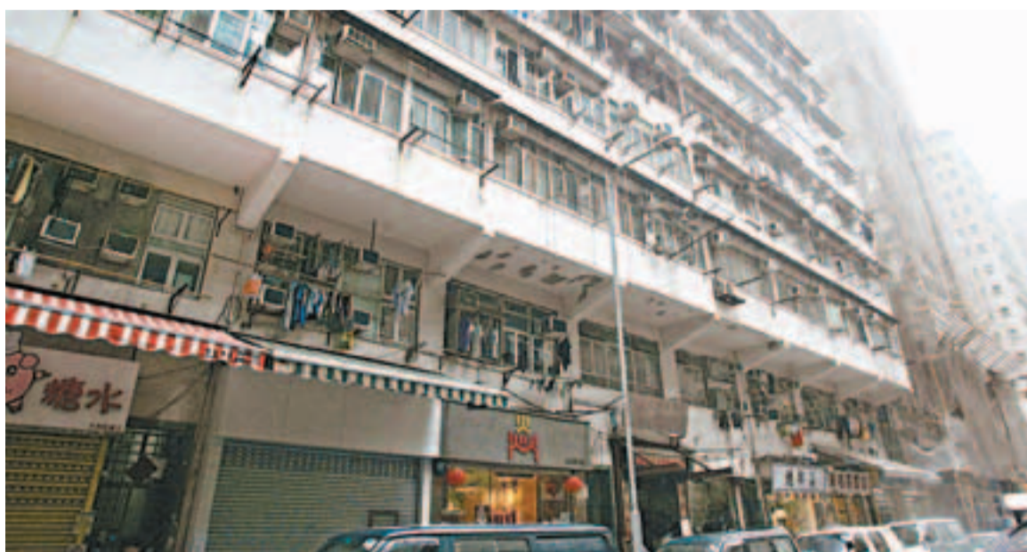
大角咀杉樹街13-31號及橡樹街87號，約70%業主同意市建局收購重建，成為首批「需求主導」重建項目。
