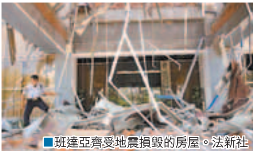
■班達亞齊受地震損毀的房屋。法新社
