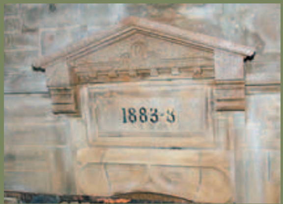
■大潭上水塘的隧道進口水口(建於1883年至1888年)
