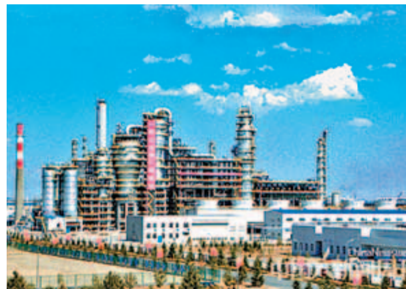
■九原工業園區煤化工項目
