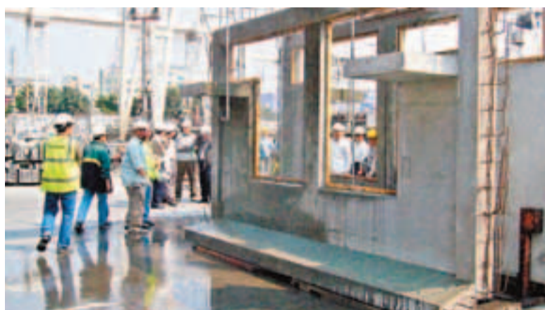
參入「礦渣微粉」的外牆組件較傳統水泥色淺，可提升混凝土的耐久性和抗腐蝕性，減低維修支出。
