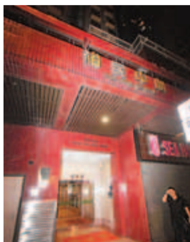
■裕民中心第2座發生升降機斷裂事故。香港文匯報記者鄭福強攝。
