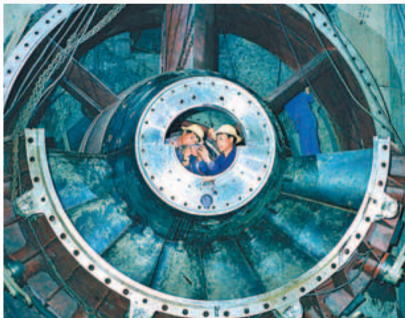
正在安裝的貫流式機組
