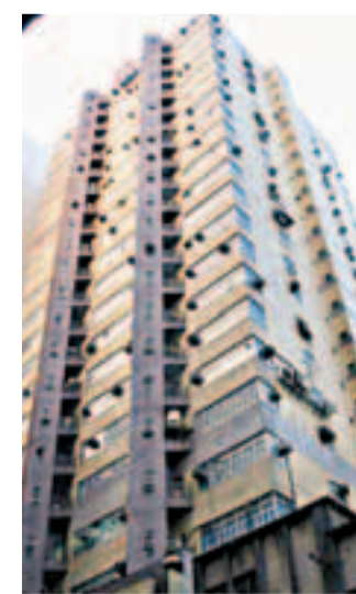
東貿廣場外景。
