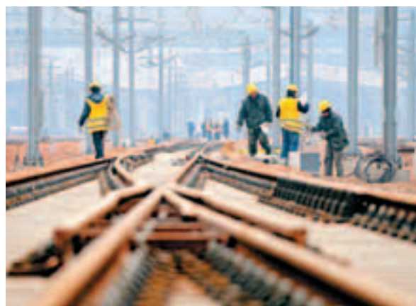
■「十二五」時期將初步形成以「五縱五橫」為主骨架的綜合交通運輸網絡。圖為京廣客運專線鄭州新東站鐵軌鋪設施工現場。資料圖片
