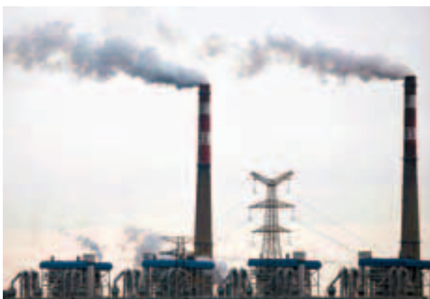
■馬建堂表示，污染物排放還是中國面臨的突出問題。圖為湖北省一家電廠煙囪排出的廢氣。資料圖片
