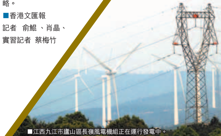
■江西九江市廬山區長嶺風電機組正在運行發電中。
