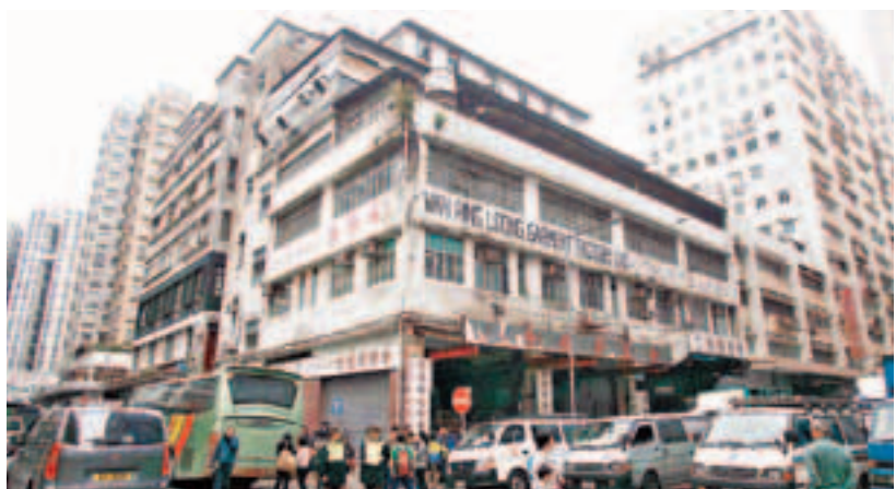
■洋松街78和78A割房工廈昨被裁判官向屋宇署頒發封閉令。
