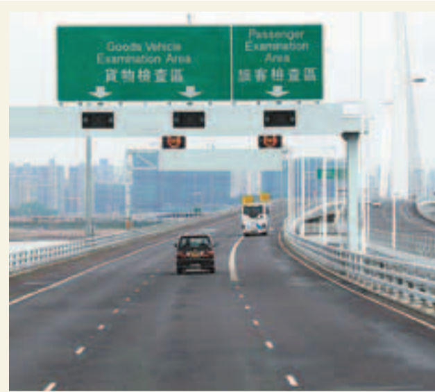
西部通道深圳灣口岸將是粵港自駕遊的通關口岸。圖為深圳灣公路大橋。
