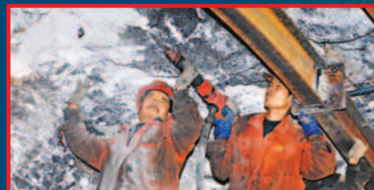
■山西築路工人在「太陽高速」施工中。
