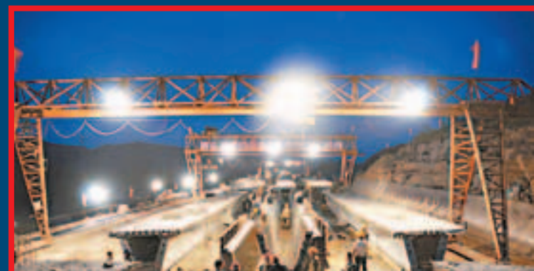
■和榆高速公路施工現場。
