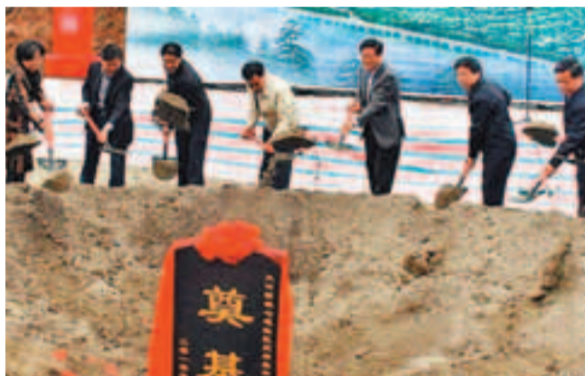
■趙正永省長為陝南地區移民搬遷集中安置點工程開工奠基。
