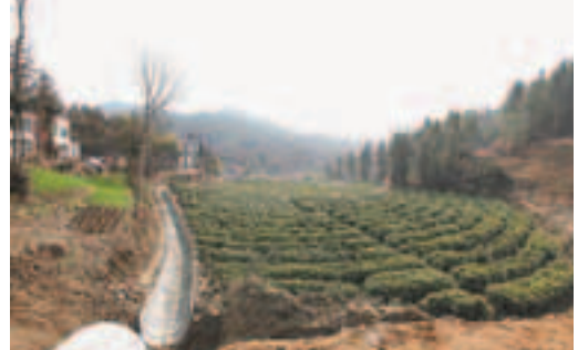
■新開挖的溝渠延伸到田間地頭
