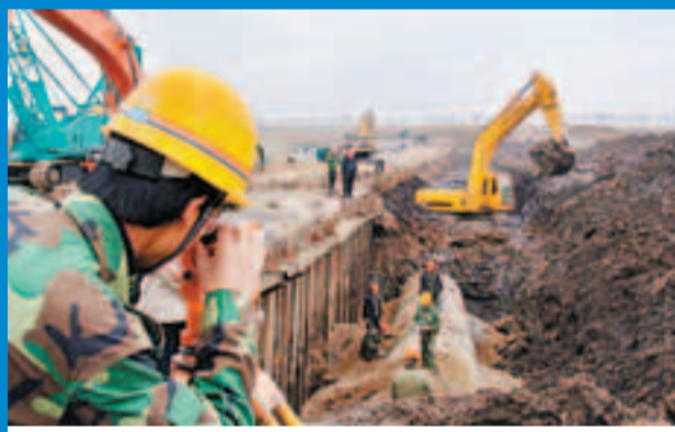
■管線施工現場
