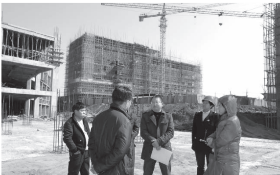
興仁縣三甲醫院建設工地。
