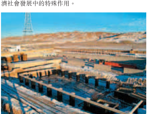
新疆有色集團伊犁循環經濟工業園建設中的原料堆場、原料車間廢房及設備基礎。
