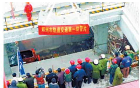
■河南省重點項目——鄭州地鐵一號線一期工程正在緊張施工。
