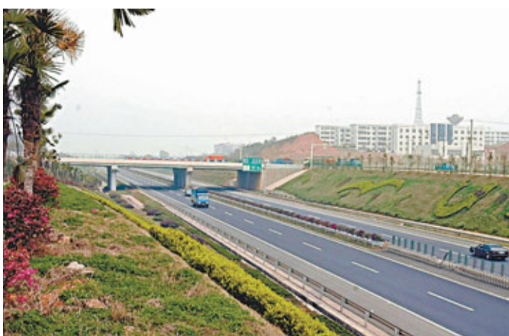
湖南省今年計劃投資750億元人民幣加快交通運輸基礎設施建設。
