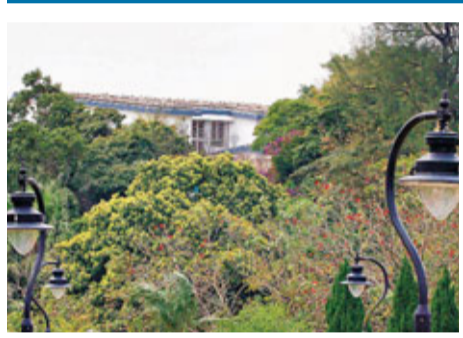
發生保安員被簷篷塌下支架擊傷的柯士甸山道3號豪宅。
