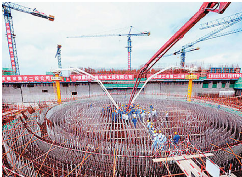
■經歷了近一年的「冬眠」,中國核電項目將會陸續恢復審批。圖為福建福清核電站2號機組核島反應堆廠房施工現場。
