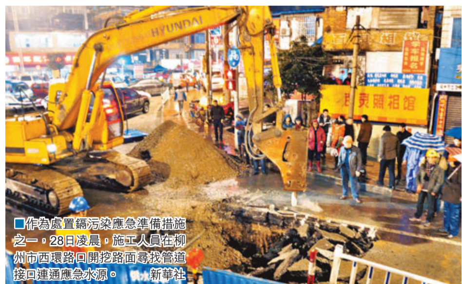
作為處置鎘污染應急準備措施之一，28日凌晨，施工人員在柳州市西環路開挖路面尋找管道接口連通應急水源。 新華社
