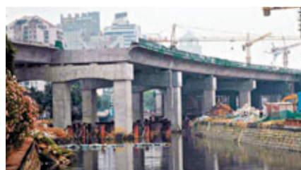
■珠海站工地裡未見工人。
