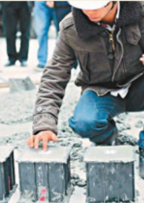
■穗在內地率先實施混凝土生產數據實時採集上傳，並植入芯片跟蹤。香港文匯報廣州傳真
