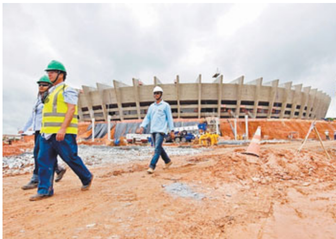
■巴西建築工人升級貝洛奧里藏特體育館設施，迎接2014年主辦的世界盃。法新社
