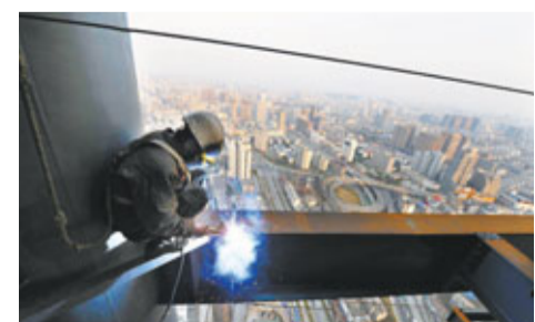
合肥一新樓盤的建築工人正在高空作業。資料圖片
