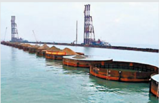
■港珠澳大橋西連接線將銜接珠海海東西部南北交通動脈。圖為人工島施工狀況。資料圖片
