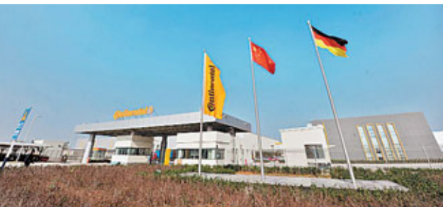
■德國大陸馬牌輪胎合肥工廠
