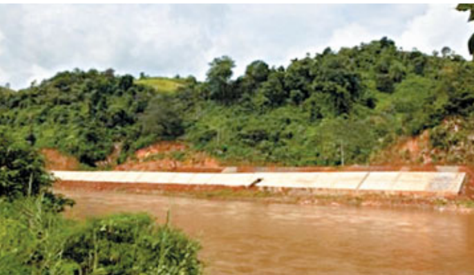
■越南在中越邊界南溪河牛頭灣興建河堤，間接令雲南河口邊境國土流失，國界線移位。網上圖片
