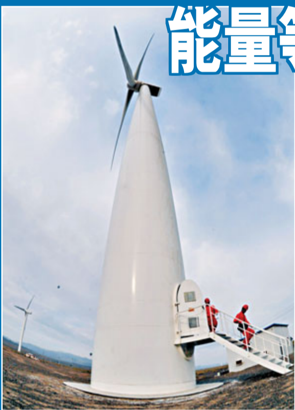
「十二五」風電開發全力推進。圖為全球最大的直驅永磁風電機組製造商之一、新疆金風科技股份有限公司一處風力發電場。新華社
