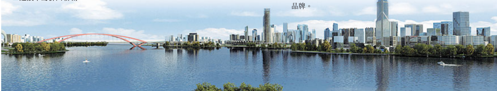
■建設中的佛山新城
