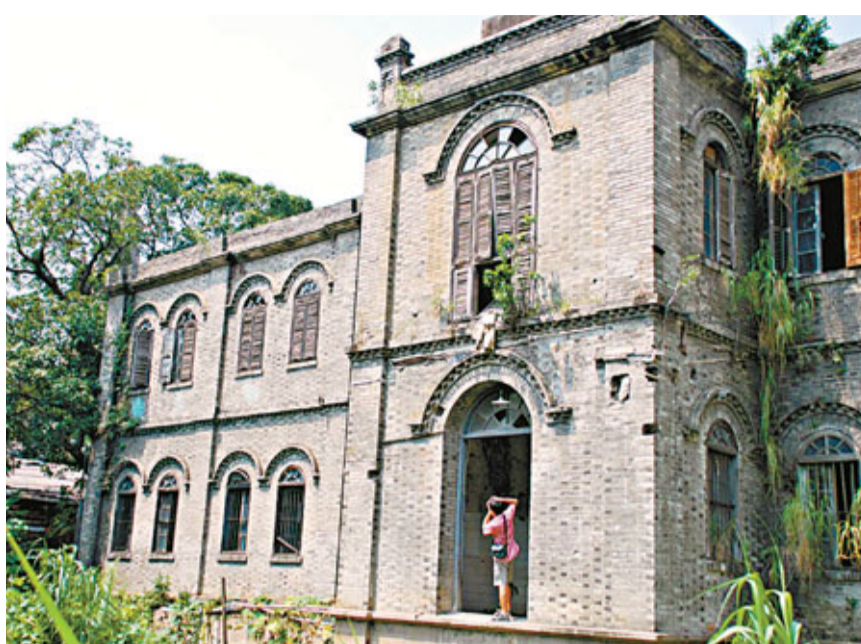
「福州老建築百科」成員池志海在實地拍攝倉山「泛船埔天主教堂神父樓」建築圖。圖片由受訪者提供
